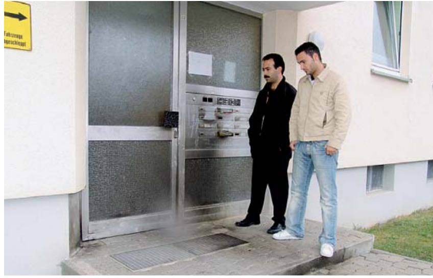
Betroffenheit herrscht nicht nur bei Hayati Hurman (links) und Güngör Önder nach dem Brandanschlag auf das Wohnhaus in der Stettiner Straße. Foto: Oberth
